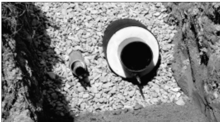
Exempel från rörgrav med Isoterm- och Isovarmrör
